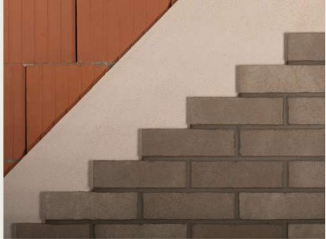
Die Gesamtdicke der beiden zusammengefügt Klebemörtelschichten beträgt so mindestens 3 mm und darf die empfohlene Schichtdicke nach Herstellerangaben nicht überschreiten. Vor und während der Verarbeitung ist der Untergrund vor einer witterungsbedingten Durchnässung zu schützen. Der frisch aufgetragene Klebemörtel ist vor zu schnellem Feuchtigkeitsentzug durch Sonneneinstrahlung und / oder Zugluft zu schützen. Daher ist eine „Einhausung“ des Gerüsts empfehlenswert.
