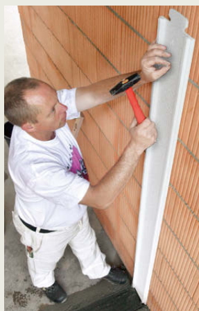
Anbringen der Entkopplungs-Ansatz-Profile (hier EAP-Wand).
