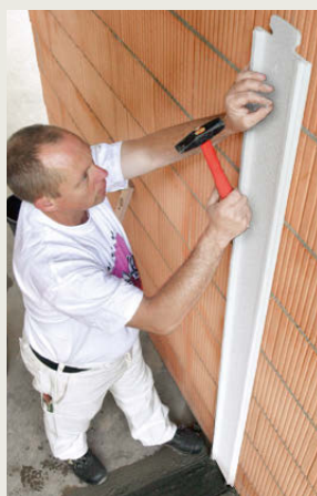
Anbringen der Entkopplungs-Ansatz-Profile (hier EAP-Wand).
