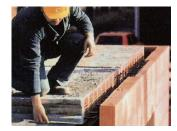
Die Mindestauflagertiefe auf Mauerwerk oder Stahlbeton beträgt 5 cm im Montagezustand. Randjoche sind im Bereich von Rollladenkästen, Stürzen und Unterzügen erforderlich, wo kein Auflager von 5 cm für den Montagezustand vorhanden ist.
