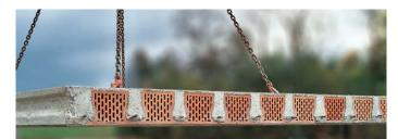
Aus speziell geformten Deckenziegeln, Baustahlbewehrungen und Vergussbeton entstehen im Werk einzelne, transportierbare Fertigelemente mit hohem Ziegelanteil. Auf der Baustelle erfolgt die Verlegung der im Regelfall 2,53 m breiten Fertigelemente mit einem leistungsstarken Baustellen- oder Autokran. Die Elemente werden nach Verlegeplan auf das mit Bitumenpappe abgedeckte Auflager verlegt.
