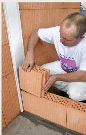
Trockenes Einsetzen (unvermörtelte Fuge zum Profil) der 11,5er Wandplatten.
