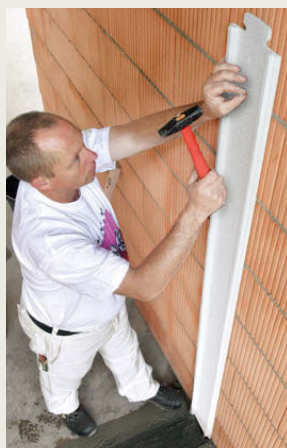
Anbringen der Entkopplungs-Ansatz-Profile (hier EAP-Wand).
