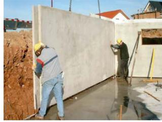
Die horizontale Montagefuge unter den Elementen beträgt 3 cm. Der Spalt zwischen Bodenplatte und Element muss satt ausbetoniert werden. Eine hohe statische Tragfähigkeit ist damit gegeben.
