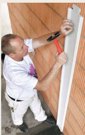
Anbringen der Entkopplungs-Ansatz-Profile (hier EAP-Wand).
