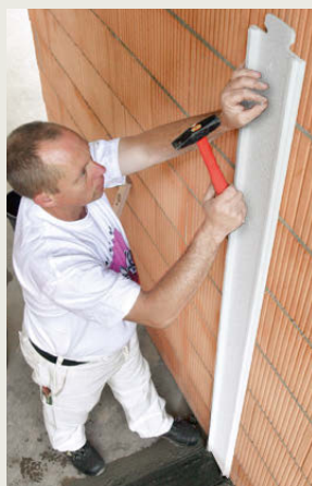
Anbringen der Entkopplungs-Ansatz-Profile (hier EAP-Wand).
