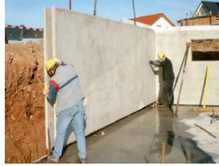
Die horizontale Montagefuge unter den Elementen beträgt 3 cm. Der Spalt zwischen Bodenplatte und Element kann satt ausbetoniert werden. Eine hohe statische Tragfähigkeit ist damit gegeben.
