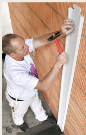
Anbringen der Entkopplungs-Ansatz-Profile (hier EAP-Wand).
