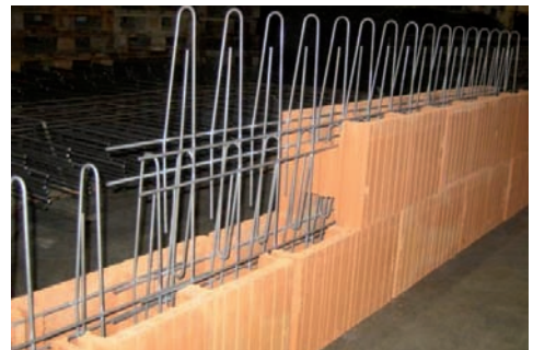
Horizontal und vertikal bewehrtes Planfüllziegelmauerwerk
