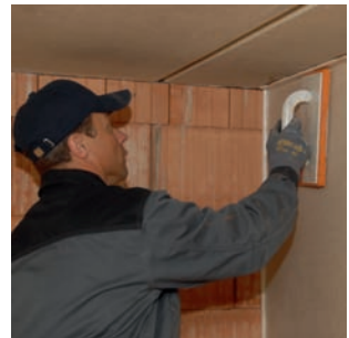
Akustische Entkoppelung von leichten massiven Innenwänden ( m' \leq 150 \text{ kg/m}^2 , nichttragende Innenraum-Trennwände nach DIN 4103) in den Anschlußbereichen zu flankierenden Bauteilen wie Wand, Decke, Boden.
