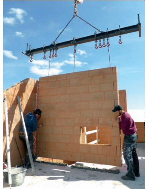
Bild rechts: Versetzen einer geklebten Mauertafel auf Unterlegplatten und Anlegemörtel. Danach werden Montagestützen befestigt und die Bauteilfuge mit Montagekleber verschlossen
