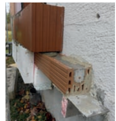
WDF auf wärmege- dämmtem Ziegelsturz und Stahlkonsole
