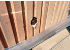
Bilder oben: Transportsystem "Innenliegende Aufhängung an Bolzen in der untersten Ziegelschicht" nach Zulassung
