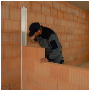
Akustische Entkoppelung von leichten massiven Innenwänden ( m' \leq 150 \text{ kg/m}^2 , nichttragende Innenraum-Trennwände nach DIN 4103) in den Anschlußbereichen zu flankierenden Bauteilen wie Wand, Decke, Boden.
