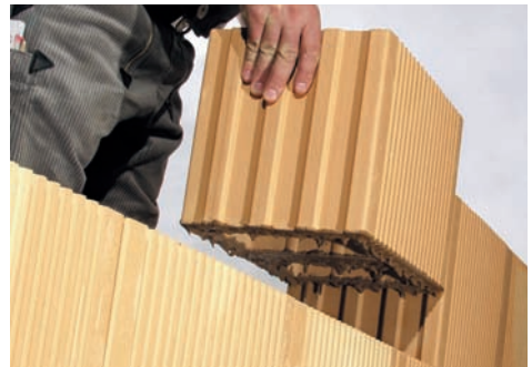
2. Mit Dünnbettmörtel benetzte Lagerfläche
