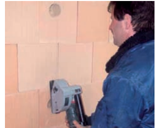
Schlitzten der Ziegel mit der Schlitzfräse.
