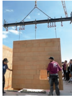
Montage Ziegelwand-Fertigteilelemente 2017 (KfW-EH-55)
