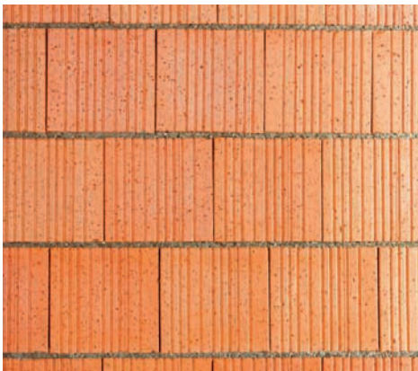
Blockziegelmauerwerk (Steinhöhe 238 mm, Lagerfuge 12 mm)
