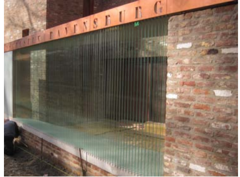
Fassade aus Recyclingziegeln, Kunstmuseum Ravensburg, 2013
