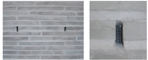
Lüftungs-/Entwässerungsöffnungen; Bild rechts: Gittereinsatz
