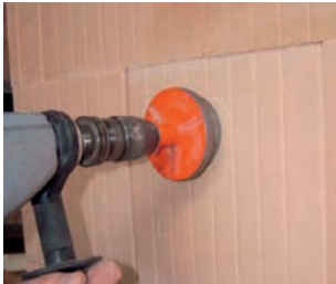
Elektrodose anzeichnen und Kernbohrung mit handelsüblicher Bohrmaschine und Diamant-Trocken-Bohrkrone vornehmen.
