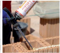
Auftrag Dryfix-Planziegelkleber
