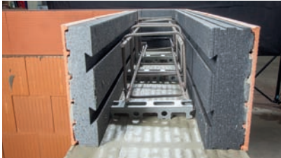
Ziegel-Wärmedämmschale mit bauseits eingebrachtem Bewehrungskorb auf Abstandhaltern vor dem Betoniervorgang..
