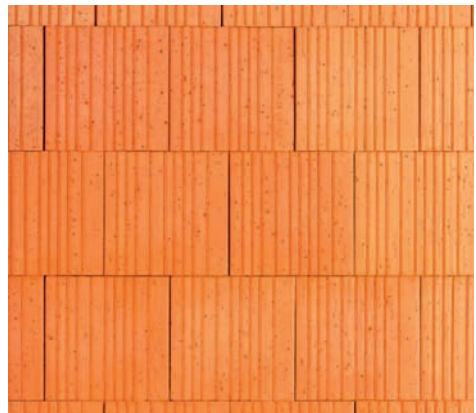
Planziegelmauerwerk (Steinhöhe 249 mm, Lagerfuge 1 mm)
