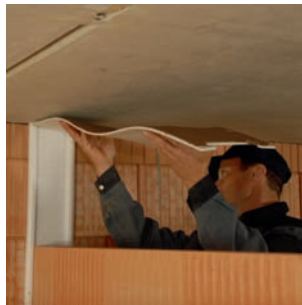
Akustische Entkoppelung von leichten massiven Innenwänden ( m' \leq 150 \text{ kg/m}^2 , nichttragende Innenraum-Trennwände nach DIN 4103) in den Anschlußbereichen zu flankierenden Bauteilen wie Wand, Decke, Boden.
