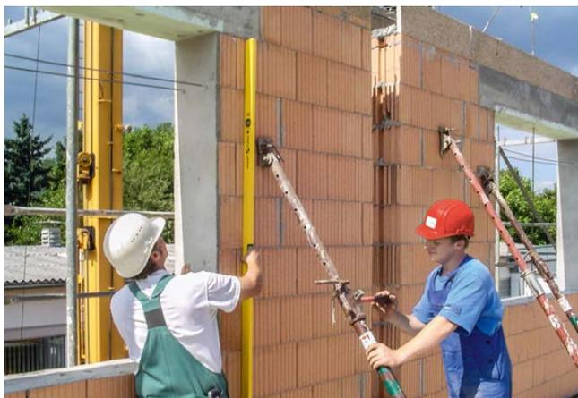
Nach dem Versetzen eines Elements werden Schrägstützen zur Lagesicherung und lotrechten Einrichtung eingesetzt.
