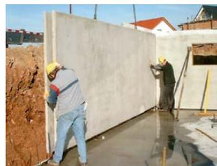
Die horizontale Montagefuge unter den Elementen beträgt 3 cm. Der Spalt zwischen Bodenplatte und Element kann satt ausbetoniert werden. Eine hohe statische Tragfähigkeit ist damit gegeben.
