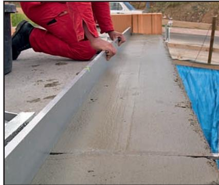
Um Unebenheiten der Bodenplatte auszugleichen wird die Mörtelgleichschicht mit Justierboy und Alulatte maßgenau angelegt und abgezogen.
