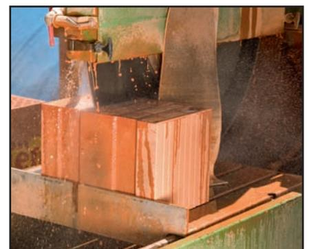
Restmaße werden mit gesägten Ziegeln geschlossen. Gesägte Flächen dabei immer nach innen richten und Stoßfugen mit LM 21 ausfüllen.
