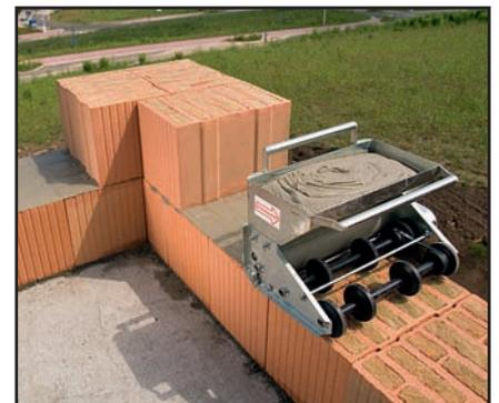
Mörtelwalze fortlaufend in eine Richtung ziehen (s. Beschriftung am Gerät), dabei die Laufrollen auf die untere Ziegellage drücken.
