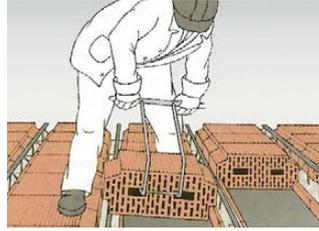
Deckenziegel werden in ausreichender Menge geliefert. Bei Querrippen, Balkonen, Abfaltungen usw. ist der Einbau von Negativziegeln (Ziegel mit geringerer Stärke als Deckenstärke) und Zulageeisen zu beachten. Genaue Angaben über Lage und Ausführung der Querrippen finden sich im Verlegeplan. Während der Arbeiten, besonders beim Einbringen des Betons, sind Punktbelastungen zu vermeiden oder durch Bohlen zu verteilen.
