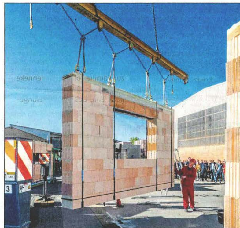
Durch den Einstieg in die Fertigteilproduktion Ziegelement werden zukünftig zwei bis vier weitere Arbeitsplätze geschaffen.
