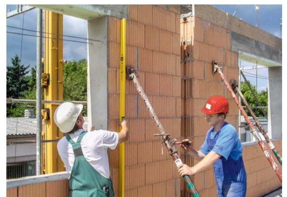
Nach dem Versetzen eines Elements werden Schrägstützen zur Lagesicherung und lotrechten Einrichtung eingesetzt.
