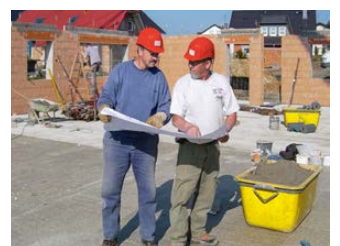
Grundlage für die richtige Positionierung der Ziegelemente ist der Montageplan.
