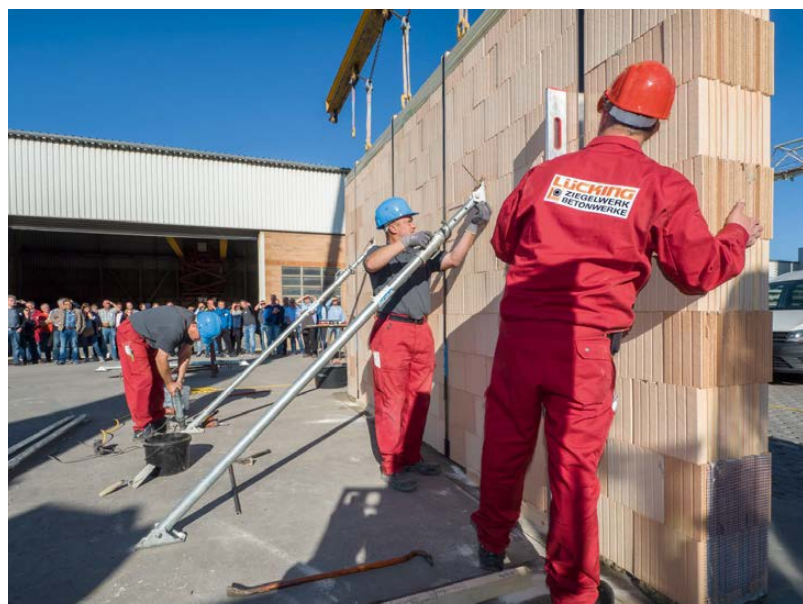
Grundlage für die richtige Positionierung der Ziegelemente ist der Montageplan.
