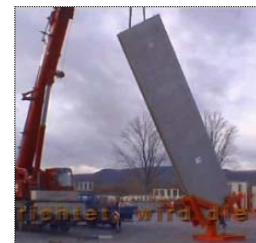
Umlenkrolle (wird an den Mobilkran angehängt)
