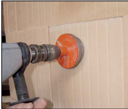
Elektrodose anzeichnen und mit handelsüblicher Bohrmaschine und Diamant-Trocken-Bohrkrone Kernbohrung vornehmen.
